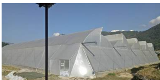
टप नेचुरल्ली भेन्टिलेटेड प्लाष्टिक घर, कास्की
